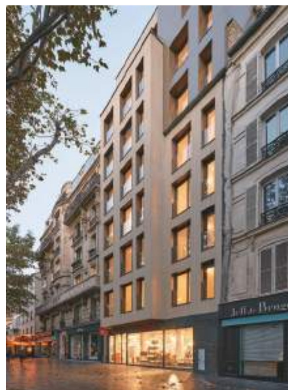
MISTRAL - PARIS | 14 Architecte : InSpace Architecture
